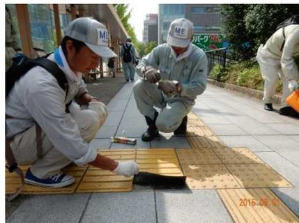
点字ブロックの補修作業
